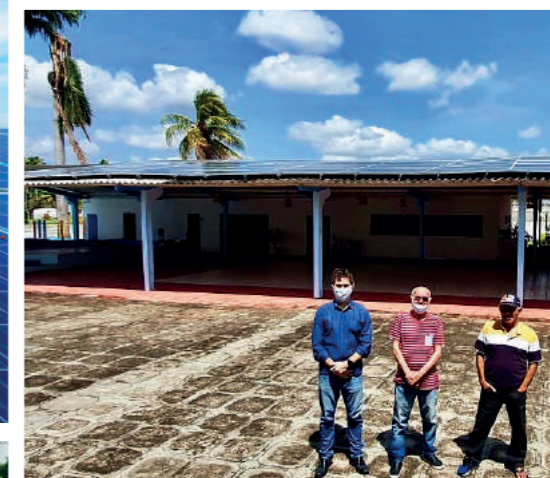
Edilson Júnior (Vice-presidente da ASFARN), José Ribamar Pinto Damasceno (Presidente da ASFARN) e Jacinto Filho (Dir. de Patrimônio e Adm), em vistoria nas instalações da usina de energia solar.
